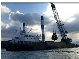
投石再配置工事
