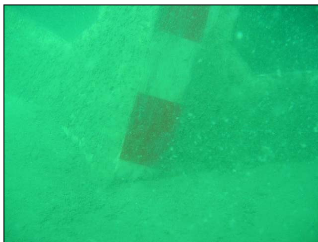
図6 AT魚礁型の埋没状況（覆砂試験区）
