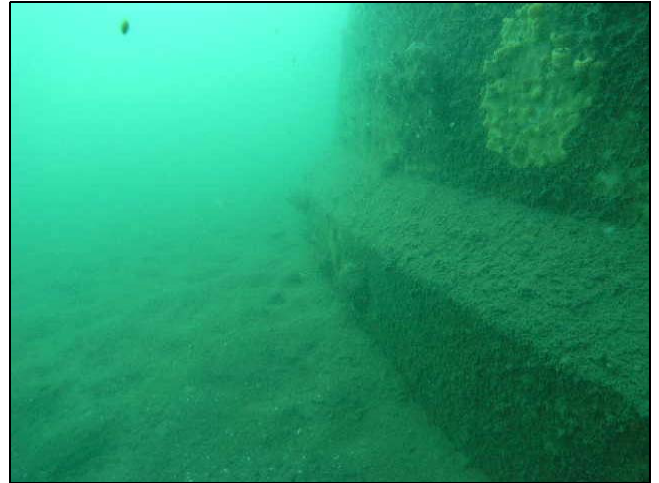
図7 魚礁の設置状況（鉄板試験区タートル型）
