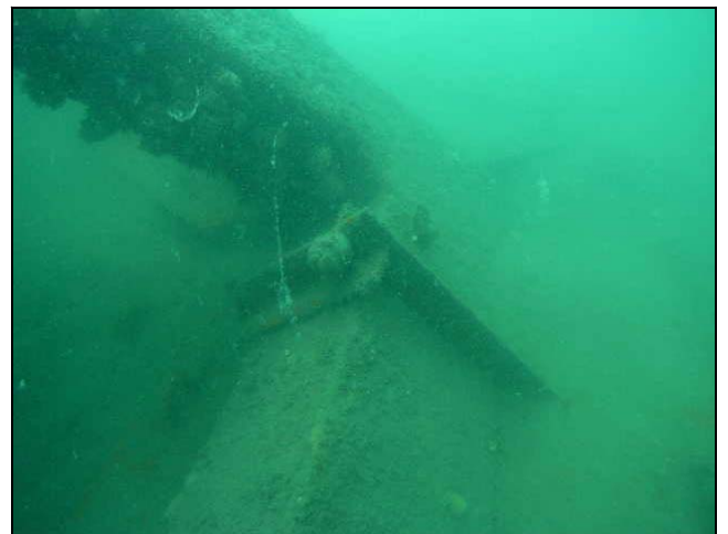
図8 魚礁の設置状況（鉄板試験区A T型）
