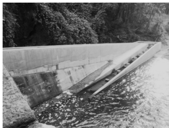
図1 第三砂防堰堤に設置された魚道
