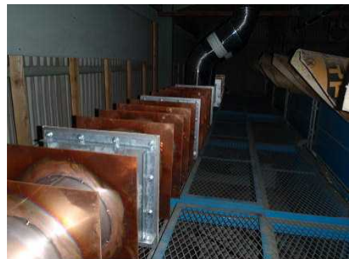
図3 改良型煙突設置状況(7連)
