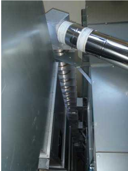
図5 改良型煙突設置状況（20連）
