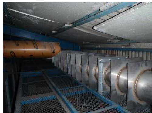
図4 改良型煙突設置状況(8連)
