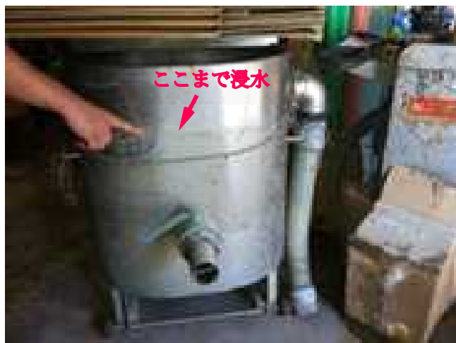
図3 周辺機械における浸水跡
