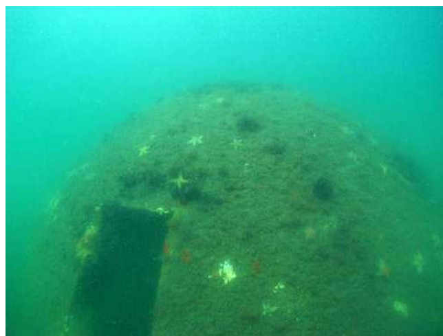
図7 潜水目視調査結果① (湧昇流発生構造物斜め上方からの状況)
