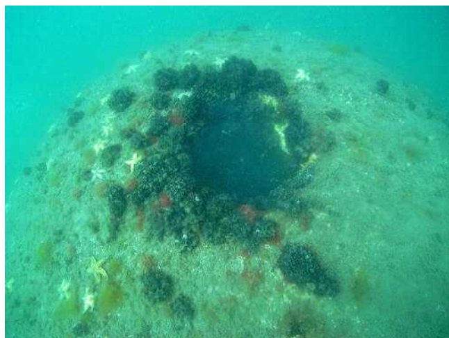
図9 潜水目視調査結果③ (湧昇流発生構造物に浮付着するサンゴモの一種)
