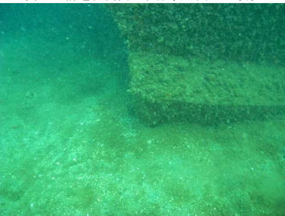
図19 構造物接地面の状況
