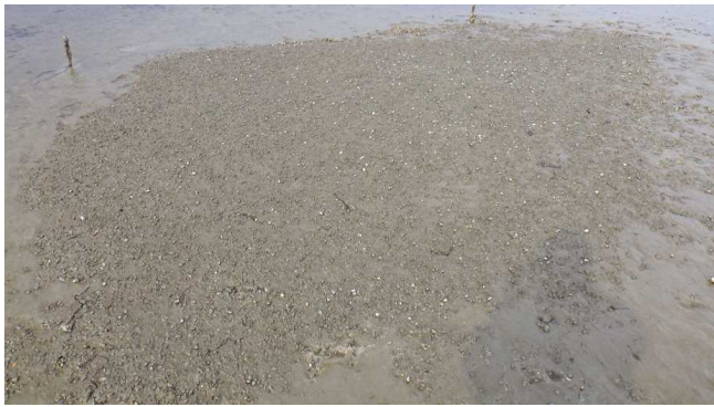
図22 砕石敷設区の状況（平成29年1月）
