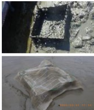
図4 ステンレスかごの設置状況 (塩塚川)
