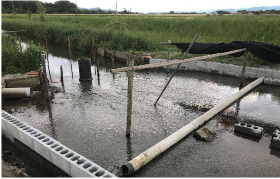
図 3 コンクリートブロックにて流量調整した スイゼンジノリ養殖場
