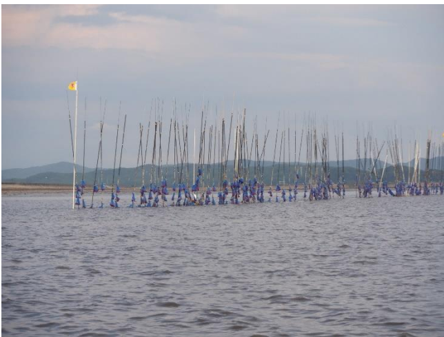
図 23 パーム袋の設置状況 (令和 3 年度設置)
