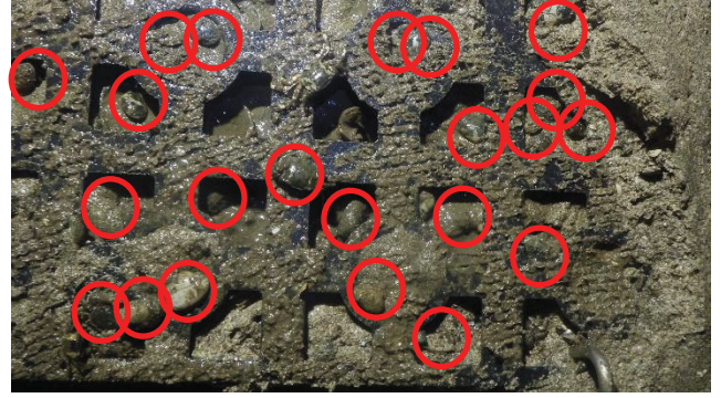
図4 二重底プレート間のアサリ (丸で囲まれた箇所)
