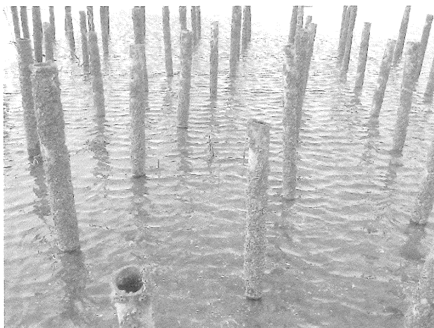
写真1 杭打ちの実施状況
