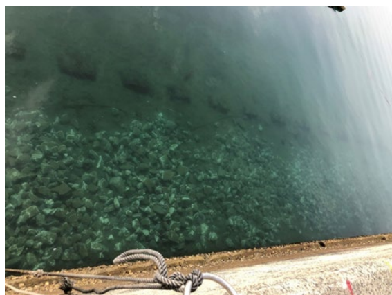
図8 投石直後の状況（漁港内投石試験区）
