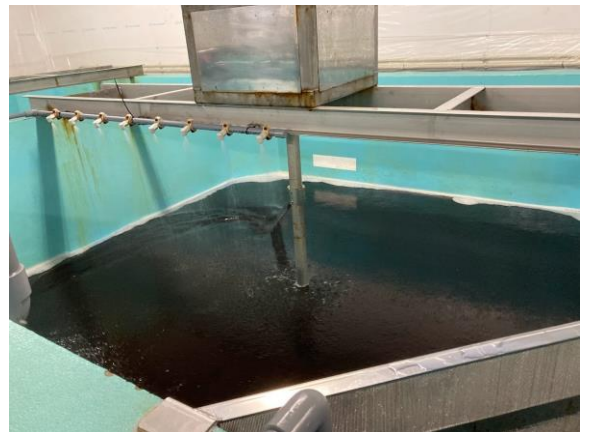
写真 ノリの貯留槽
