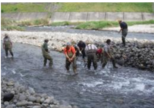
造成作業の様子（矢部川）
